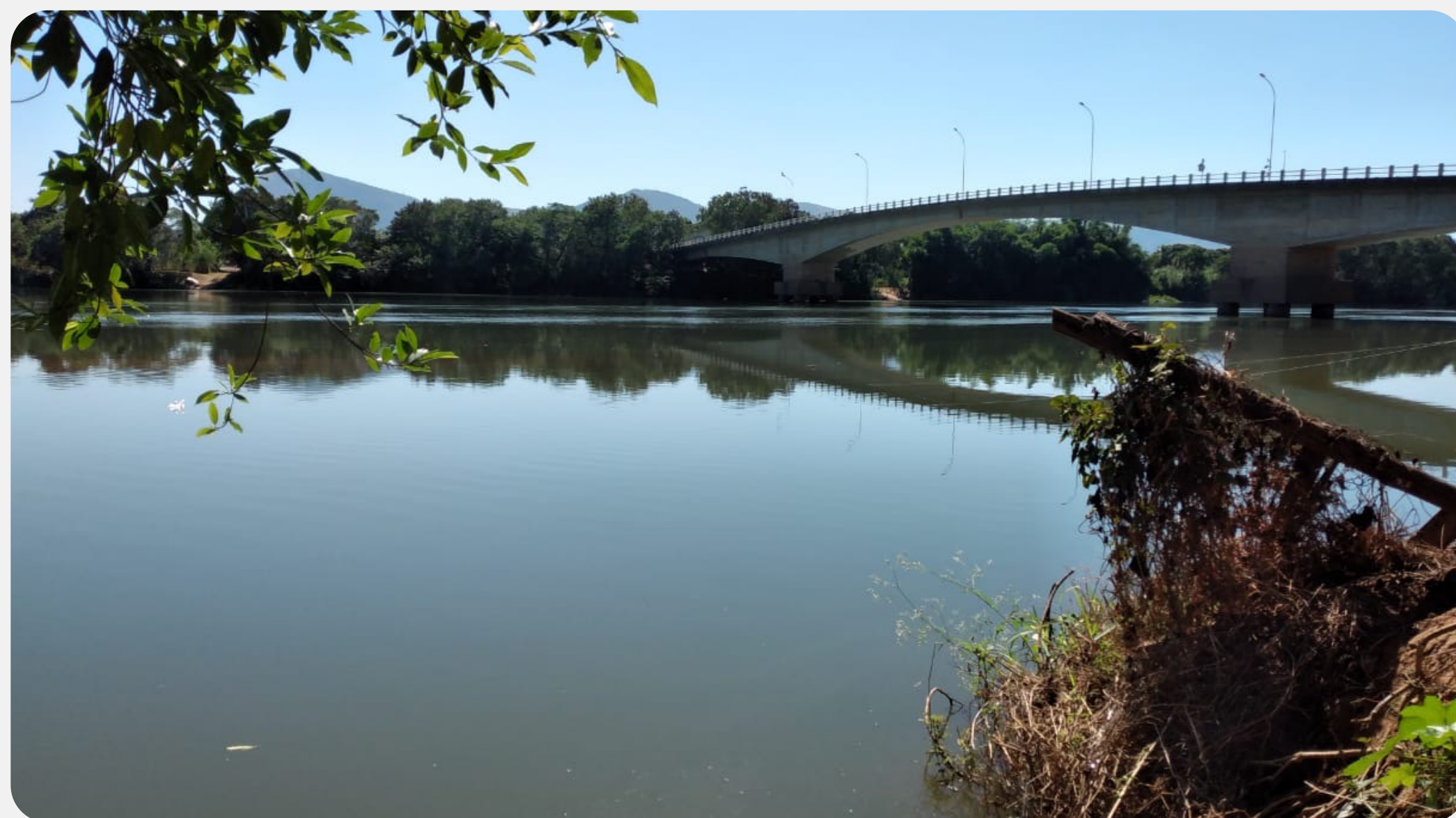
Foto 7 - Estação P-04 em maio de 2024.
