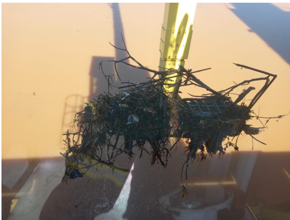
Foto 6.1-4 Limpeza Grade Casa de Força
