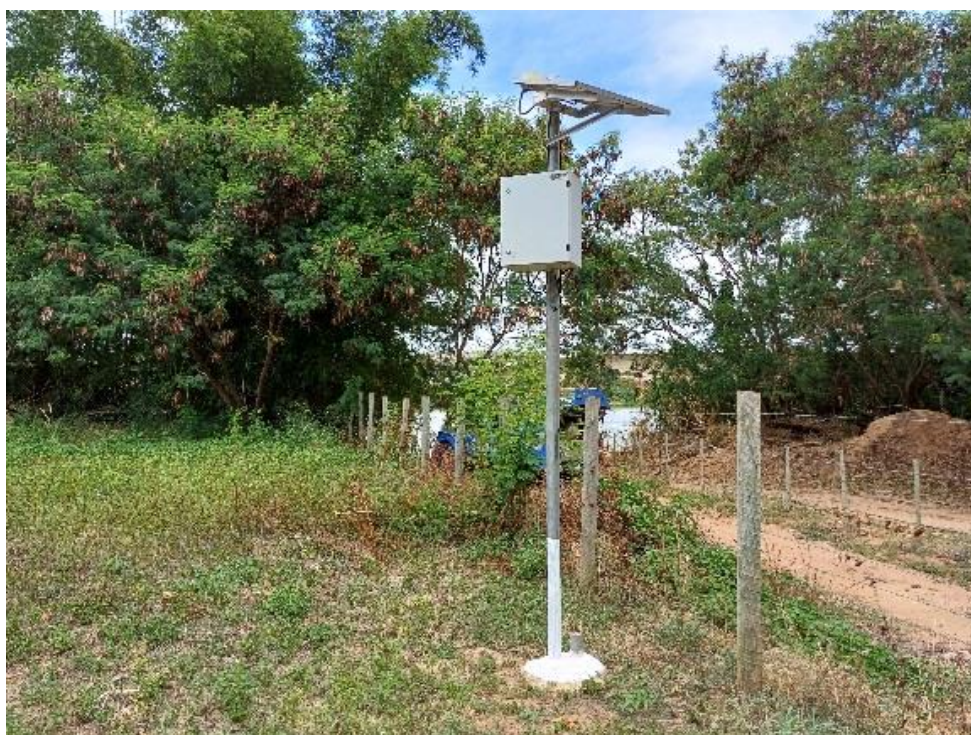
Foto 6.2-6 Manutenção preventiva e operações hidrométricas na estação UHE Mascarenhas Montante 2.
