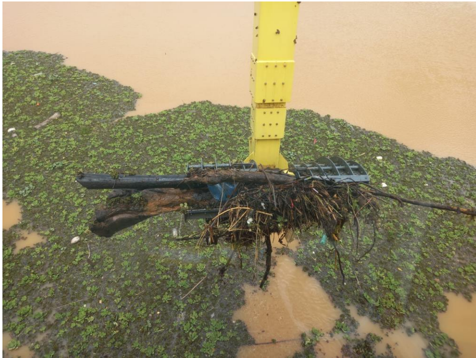
Foto 6.1-3 Limpeza Log Boom
