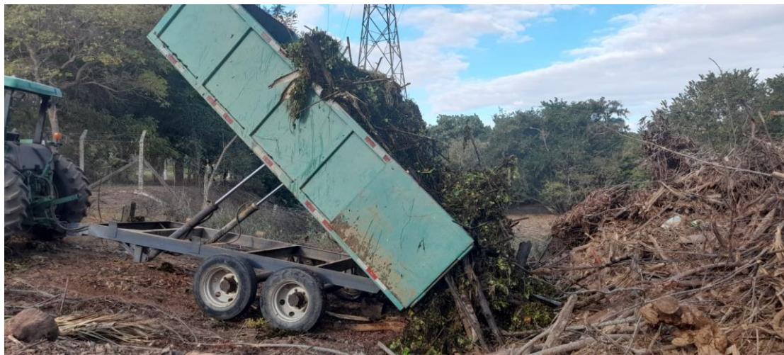
Foto 6.1-7 Descarregamento dos resíduos do Log Boom e grades da Casa de Força para a compostagem
