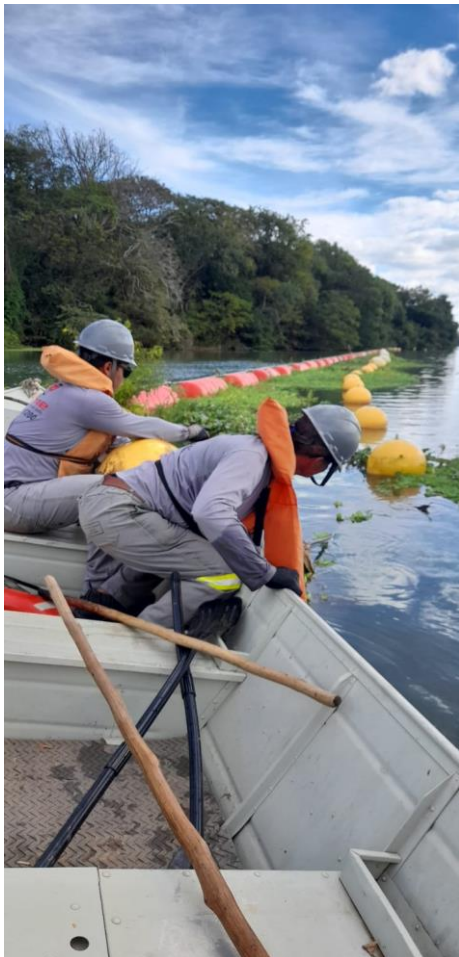
Foto 6.1-1 Limpeza Log Boom
